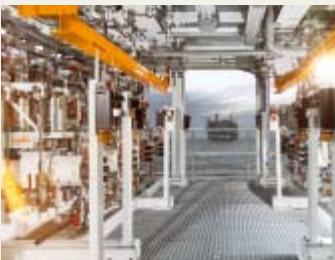
Inbetriebnahme vor Ort
